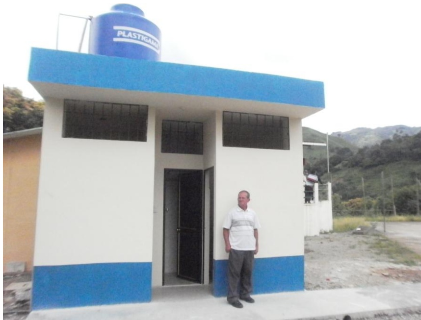
Construcción de Baterías Sanitarias en el Sitio La Lejanita
