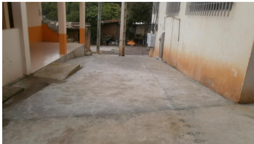
Pavimentación de la entrada a las baterías sanitarias del centro parroquial
