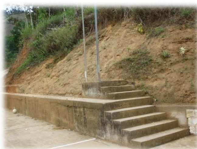
Construcción de escalinatas en el sitio Mochata
