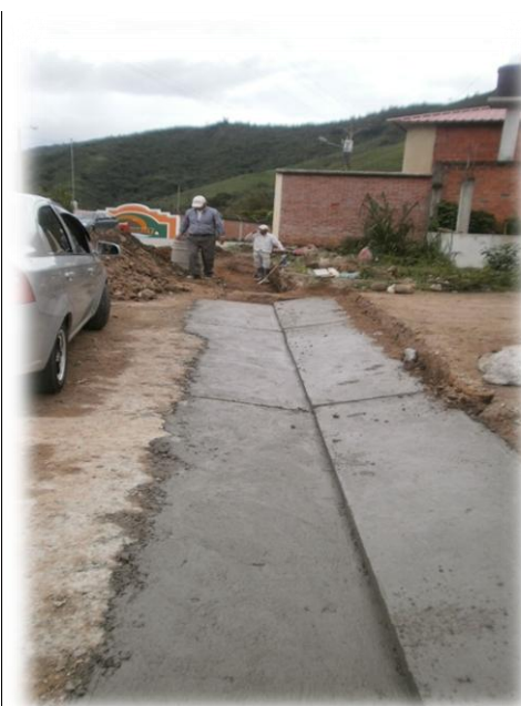
Construcción de cunetas en el Sitio Tarapal
