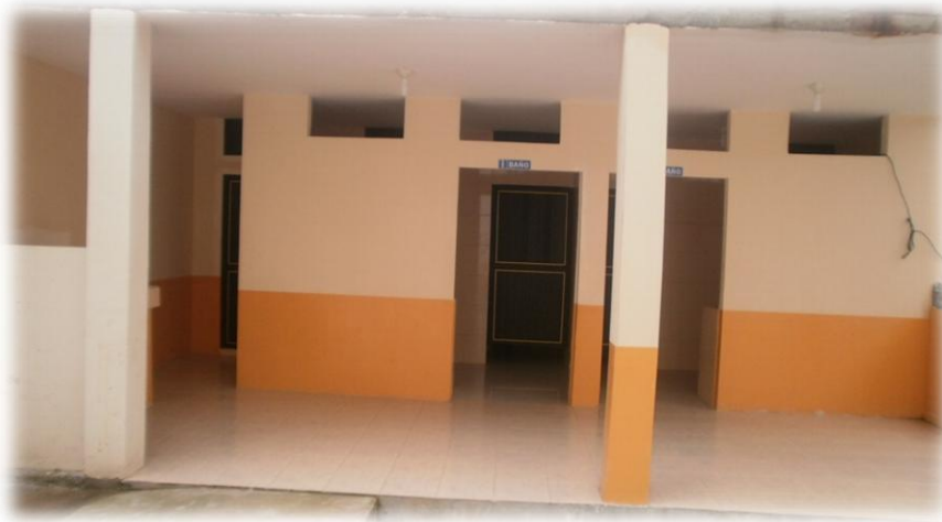
Construcción de Baterías Sanitarias en la parroquia San Roque
