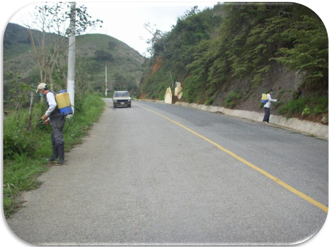
Mantenimiento de la vía Portete-San Roque
