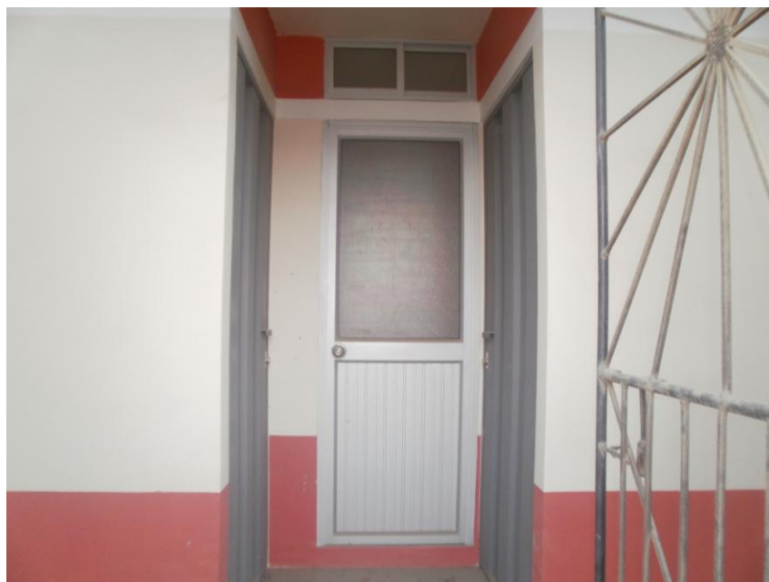
Construcción de Baterías Sanitarias en el Sitio Curitejo
