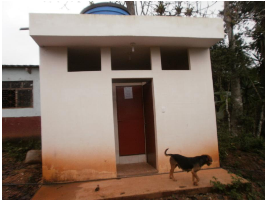
Construcción de Baterías Sanitarias en el Sitio Lozumbé
