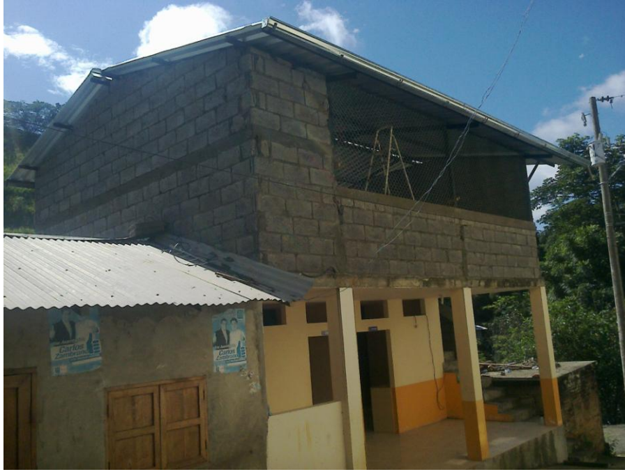
Construcción de un local para dictar talleres a la comunidad
