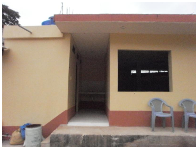
Construcción de Baterías Sanitarias en el Sitio La Chuva
