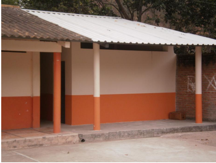
Construcción de Baterías Sanitarias en la Escuela Dr. Guillermo Guzmán Ayora
