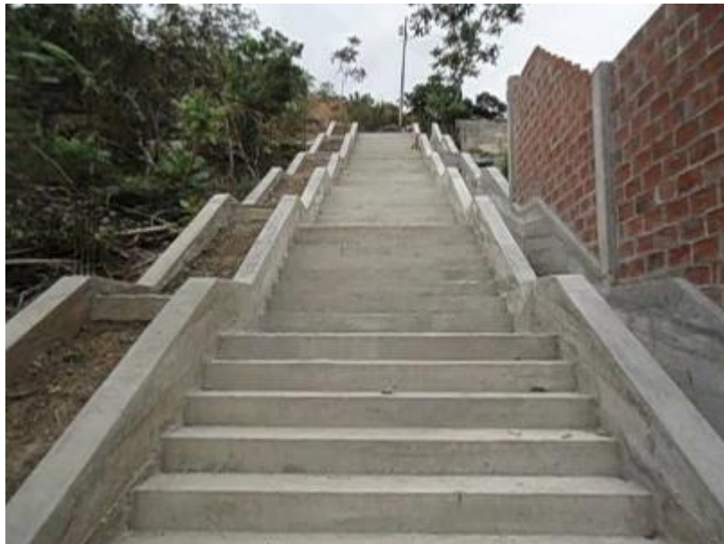
Construcción de escalinatas en el Sitio Tarapal
