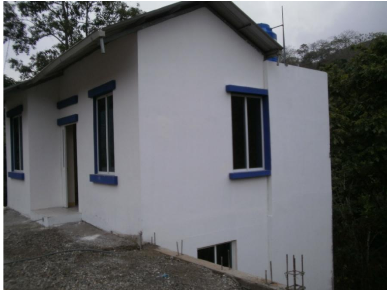
Construcción del Retén Policial de la Parroquia San Roque
