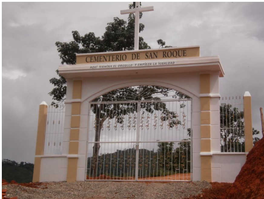
Construcción de Cerramiento del Cementerio General de la Parroquia San Roque
