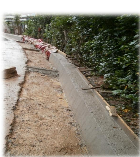
Construcción de cunetas en el Sitio Tarapal
