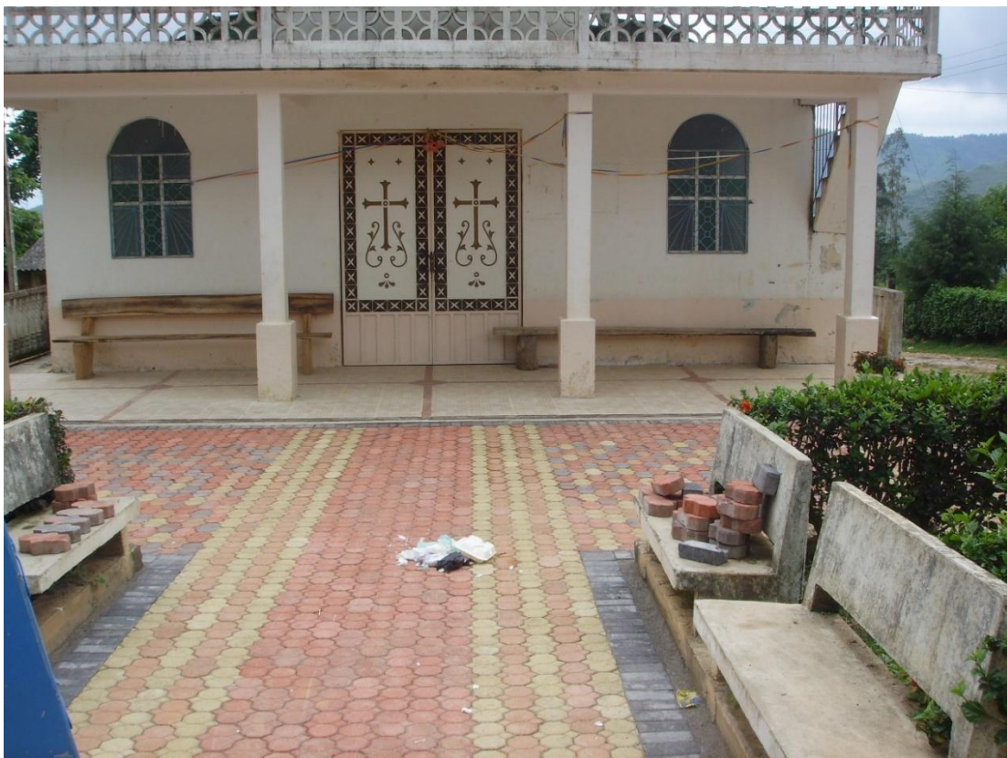
Adoquinamiento y colocación de cerámica en el parque del sitio La Chuva frente a la Iglesia
